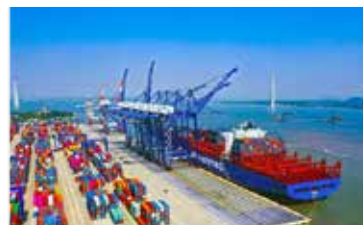
Dự án Trung tâm logistics, cảng thủy nội địa Ninh Giang (Hải Dương)
