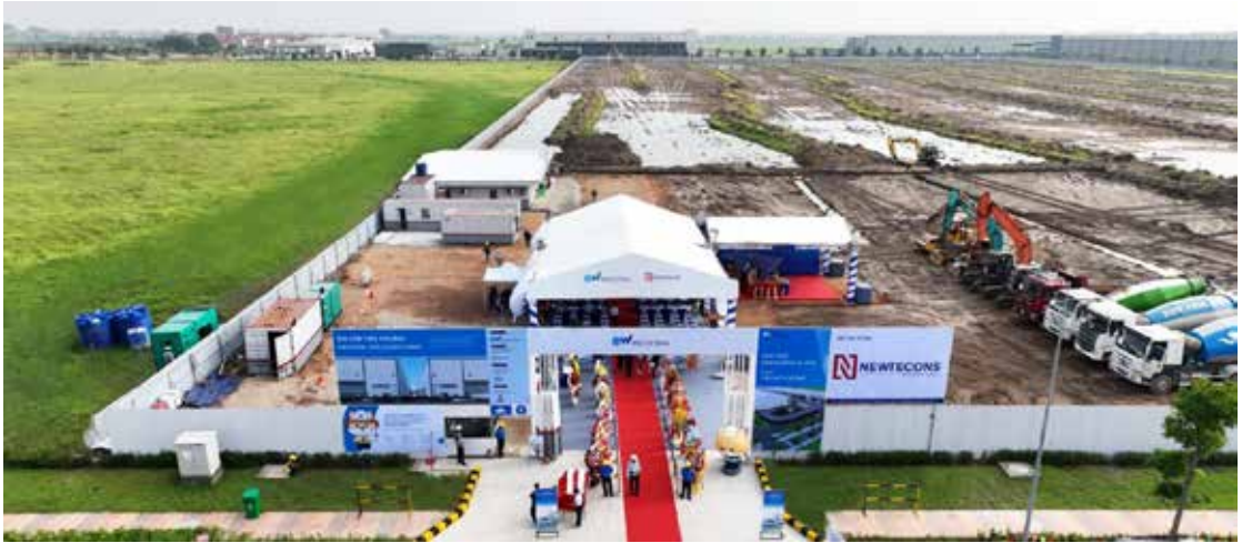
Lễ khởi công dự án nhà kho 2 tầng Nam Sơn Hạ Lĩnh tháng 6/2024
