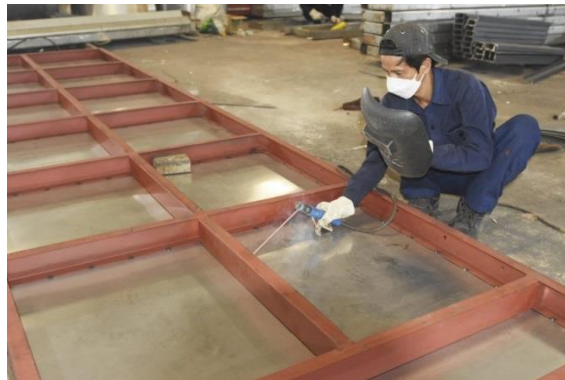
Công nhân công ty lắp ráp vách ngăn lò sấy tại Xưởng cơ khí
