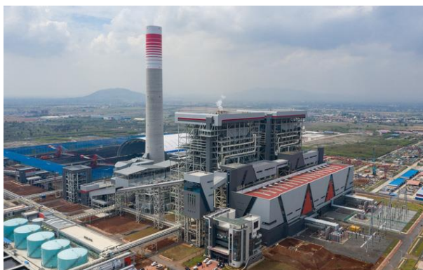
Trung Quốc đang đẩy mạnh xây dựng các trạm tích trữ điện trên khắp cả nước. Ảnh minh họa: Xinhua
